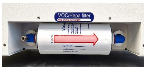
Slika 12.3 Pravilno ugrađen VOC/HEPA filtar
